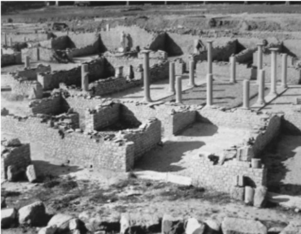
*Maison du Buste en Argenteuil en 1943. Des murs sont entièrement démontés. Le remplacement de la chaux par du ciment (expérimentation voulu par Maurice Burrus) va bloquer l'humidité dans les moellons et accélérer leur fissuration.*
